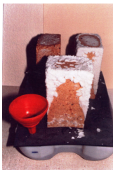
Figura 2 - Sali da evaporazione di risalita in laboratorio in diversi mattoni
